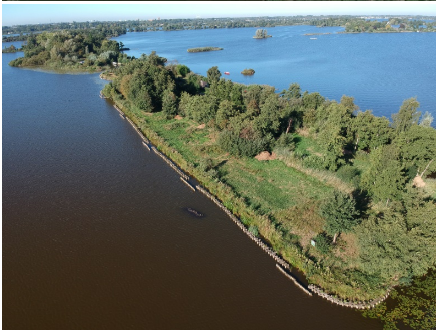
Zicht op De Schuurwerf vanuit het oosten, 300 meter oeverlengte
